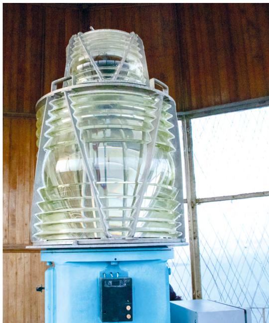
Это сердце маяка — светодиодная лампа. С наступлением сумерек она включается автоматически. «Здесь раньше были киловаттная лампа и вращающаяся оптика. Лампа горела, оптика вращалась при помощи линз, свет фокусировался в луч и шёл по горизонту. Он делал два оборота в минуту, проходил через судно, и его было видно как проблеск. Потом поставили светодиоды, они экономичнее, потребляют полтора вольта — намного меньше, чем обычные лампы», — объясняет Виталий Николаевич.
